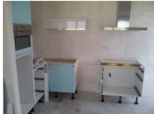
Plaatsen van nieuwe keuken
