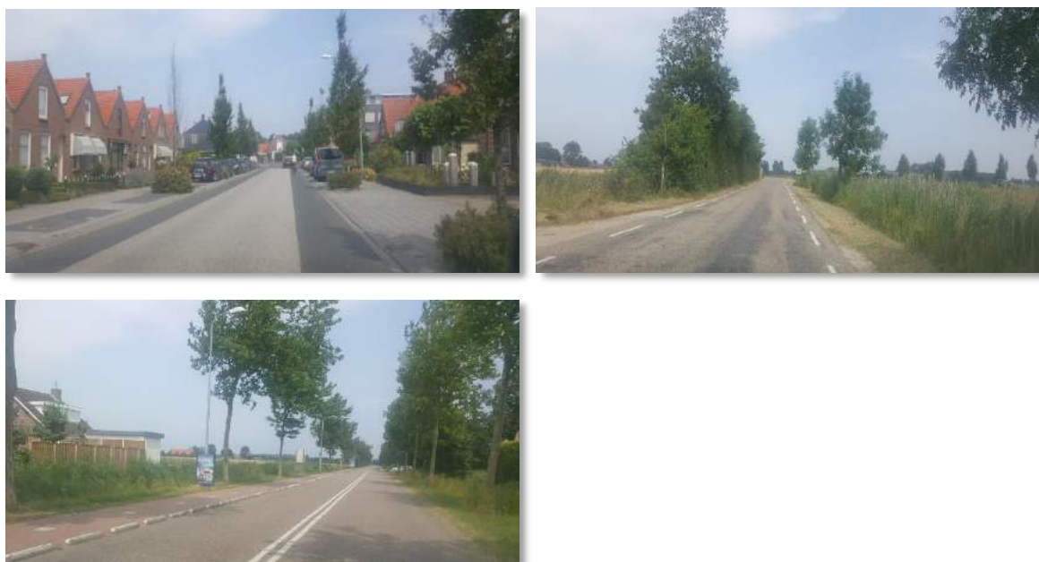
Foto 1: boven: rijbaan gemengd verkeer (links BIBEKO, rechts BUBEKO) en onder fietspad in twee rijrichtingen met beperkte ruimte tussen berm.
