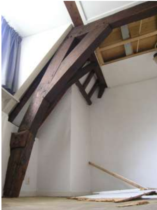
Verwijderen zachtboard plafonds
