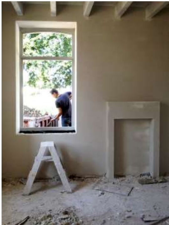
Vervangen pleisterwerk
