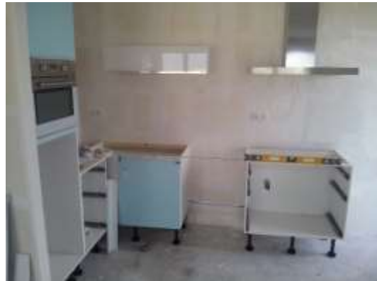
Plaatsen van nieuwe keuken
