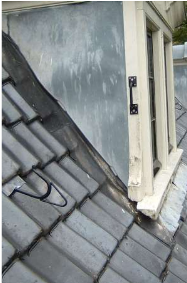
Enkele voorbeelden van ladderhaken en veiligheidsogen zoals ze conform deze flitstoets kunnen worden aangebracht en een voorbeeld van een tekening van de plattegrond van het dak waarop veiligheidsvoorzieningen zijn aangegeven.
