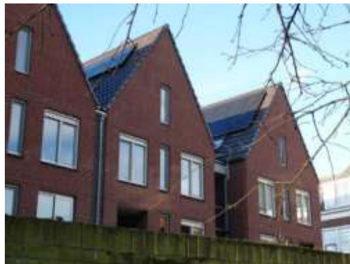
Zonnepanelen in dakvlak
